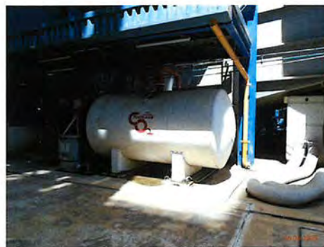
ภาพที่ 2-44 CO 2 Extinguishing System
