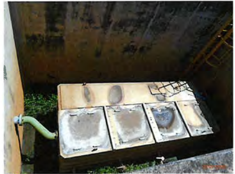
ภาพที่ 2-10 บ่อดักไขมัน-น้ำมัน (Oil-Separator))
