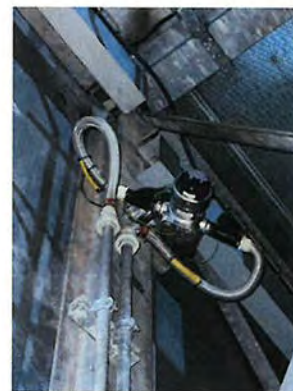
ภาพที่ 2-52 ระบบตรวจจับเพลิงไหม้ บริเวณ Gas Turbine Enclosure (Fire Cross Zone Detection)
