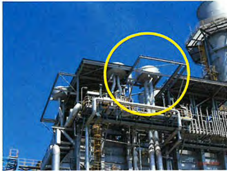
ภาพที่ 2-17 ระบบ Silencer
